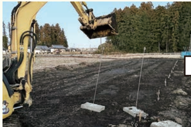
2022.12月 アンカー打ち
