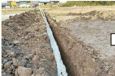
2022.12月 暗きょ排水工事
